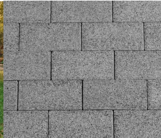
Voetpad langs rijweg, betonstraatsteen, dikformaat, Basalt toplaag
