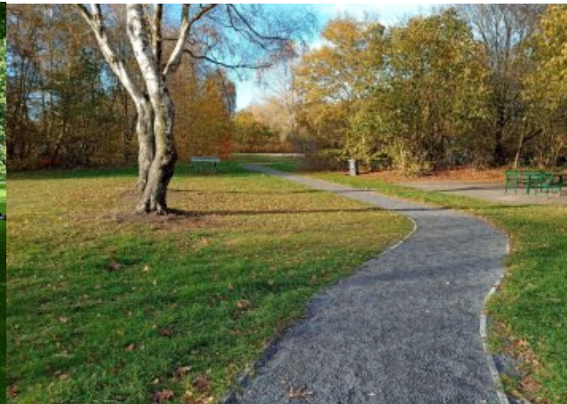
informele parkpaden, gestabiliseerde halfverharding type Stabilizer, kleur 'Hansa mix' (Ecodynamic) met opsluitbanden (uit het zicht)
