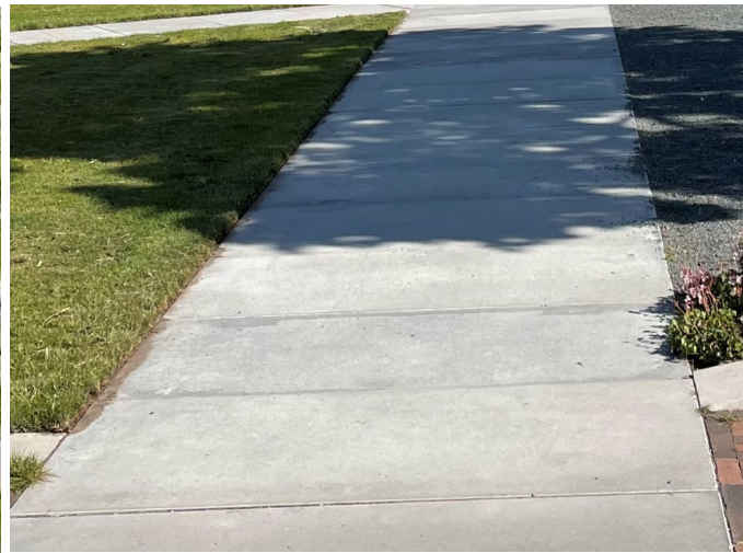
toegangspaden, betonnen grootformaat tegels, formaat kleur lichtgrijs, 80 x120cm
